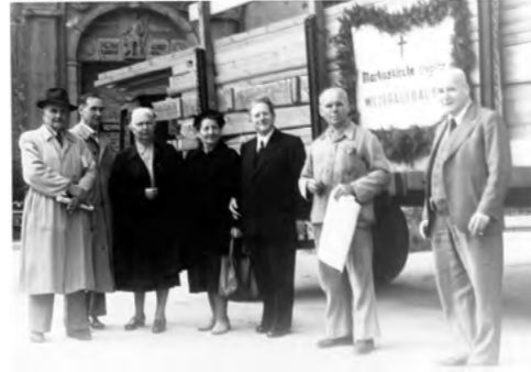
Holzlieferung für den Wiederaufbau der Markus-Kirche
