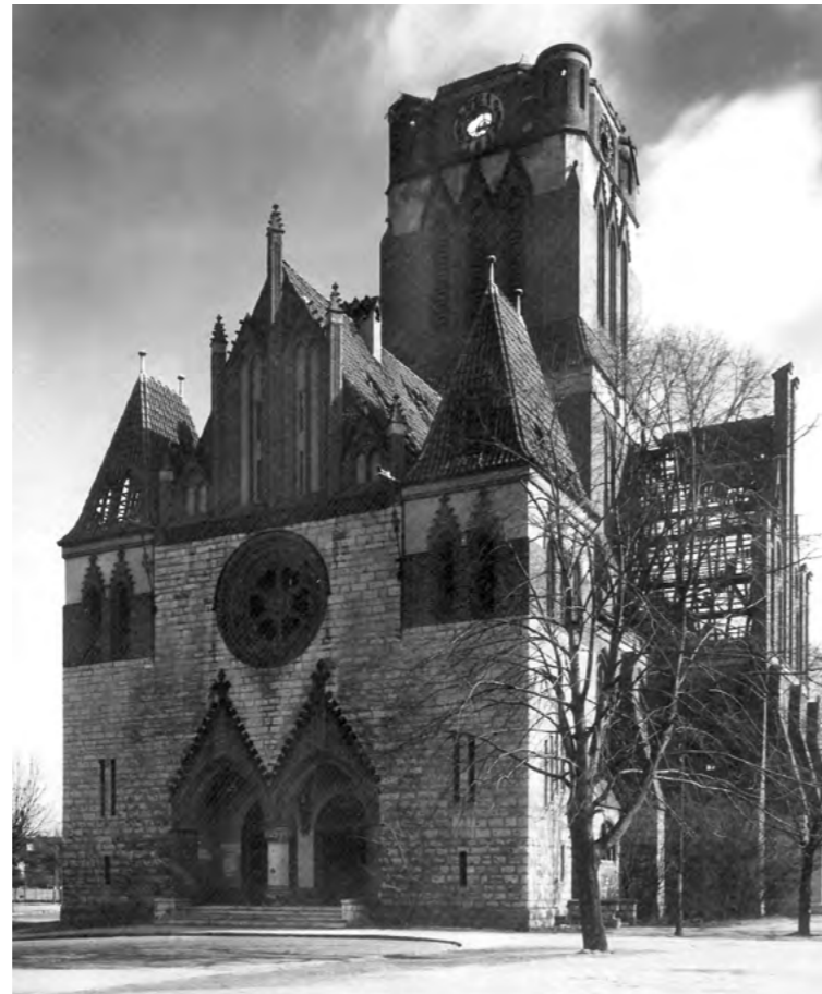
Dreifaltigkeitskirche, zerstört in der Nacht zum 24. August 1943
